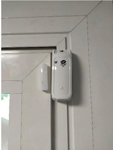
Figure 13 : contact de porte
