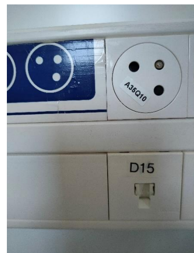
Figure 28 : étiquetage des prises côté salle blanche
