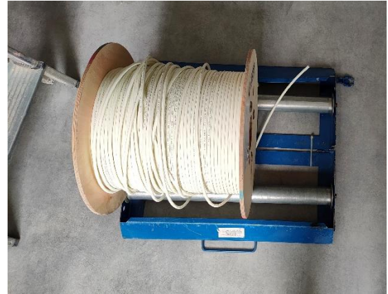
Figure 31 : tirage des câbles
