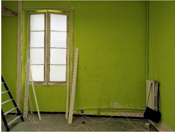
Figure 31 : tirage des câbles
