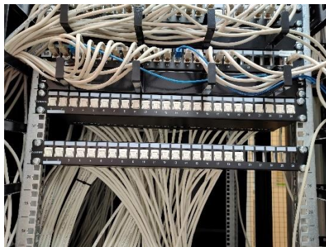
Figure 25 : préparation des prise côté baie
