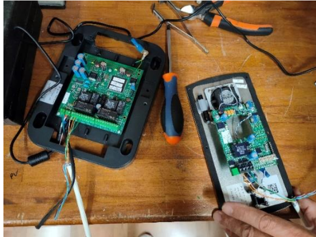
Figure 17: test sur le digicode
