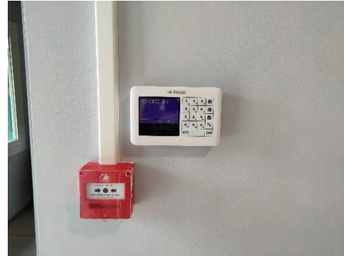
Figure 14 : fixation de la centrale à l'entrée du bâtiment
