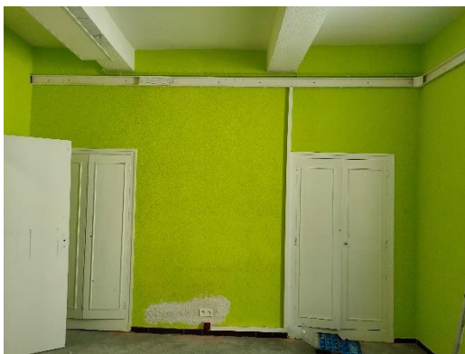
Figure 30 : positionnement des goulottes
