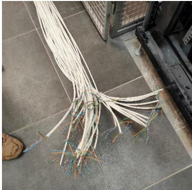
Figure 25 : préparation des prise côté baie
