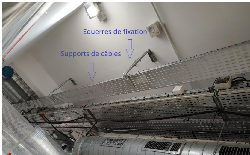
Figure 23 : fixation des supports de câbles
